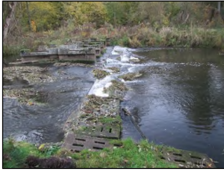
2021 – Ist-Zustand Brückenreste – vor Baubeginn
