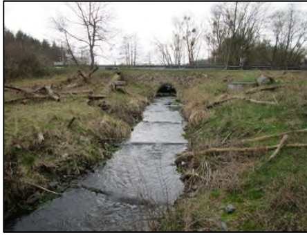
2021 – Ist-Zustand FAA – vor Baubeginn
