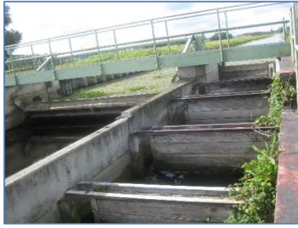
2019 vor Baubeginn © StALU VP
